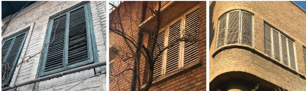
شکل ۱. نمونه‌هایی از سایه‌بان‌های متحرک الحاقی در ساختمان‌های مسکونی شهر تهران
