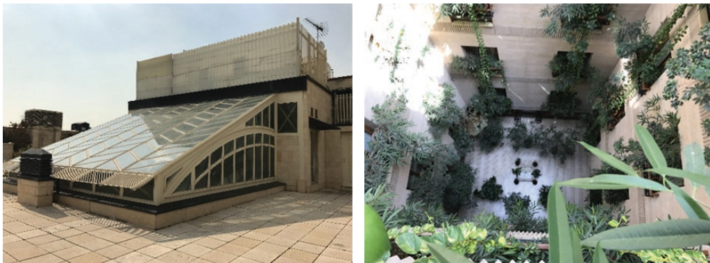
شکل ۲. فضای داخلی و پوشش نورگیر ساختمان بهاران
