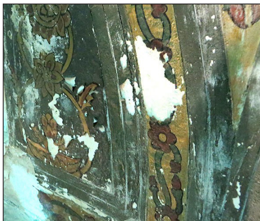
شکل ۱۷. آسیب تزئینات روی گچ بخش فوقانی بقعه شاه‌عباس ثانی
