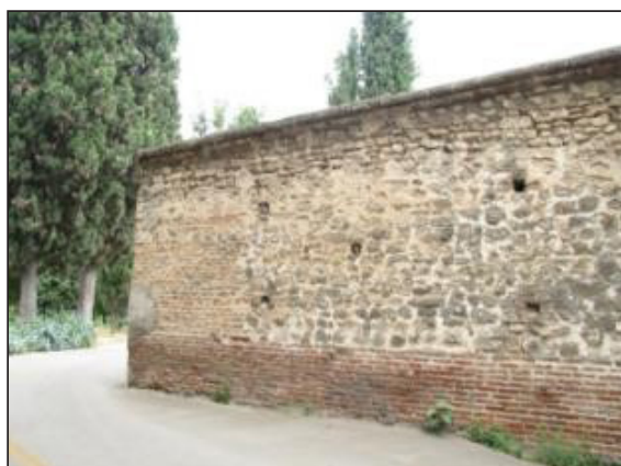
شکل ۱۹. تصویر بخشی از حصار اصیل موجود در باغ که قسمت‌های آجری و سنگی آن به‌وضوح مشخص است منبع: نگارندگان
