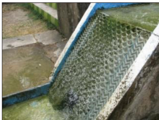
شکل ۱۱. تصویری از سنگ‌های تراش‌خورده که در مسیر آبروهای باغ قرار داده شده است
