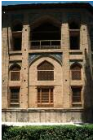
شکل ۳. نمای آجری بنا
