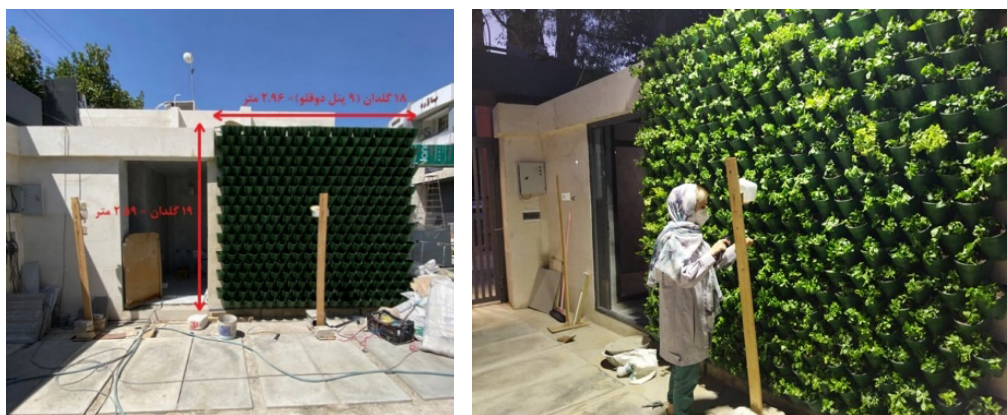
شکل ۳. عکس دیوار سبز مجموعه و ابعاد و اندازه‌های آن
